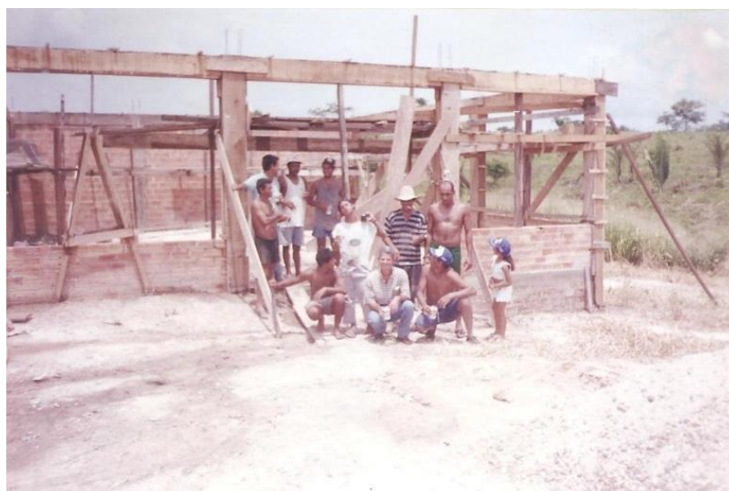
Fotografia 12 – Construção da Comunidade Católica Santa Perpétua, 2000 (IFRO, 2014).
