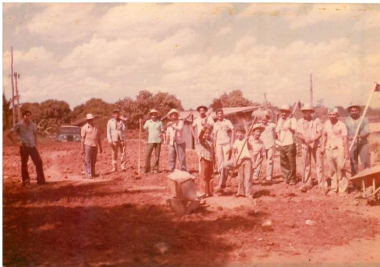
Fotografia 11 – Fiéis preparando o terreno onde seria construída a Igreja em 1976 (IFRO, 2014).
