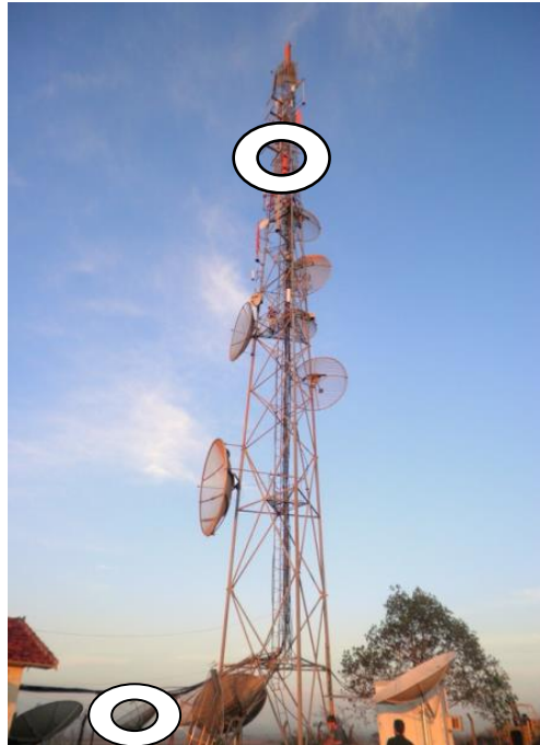
Figura 7: Perspectiva da antena geral de retransmissão de sinal de TV do Município de Ourinhos. Essa antena é responsável pela acomodação dos aparelhos emissores das diversas TVs abertas da cidade. Na parte debaixo da foto, em destaque com “círculo”, a antena da TV Novo tempo (forma de parabólica), que apara o sinal do satélite
