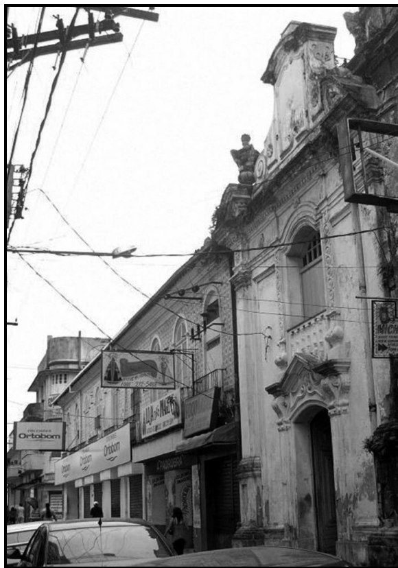
Fig. 1 – A Capela e o sobrado ao qual esteve ligada Fonte: Domingos Oliveira, 2008
