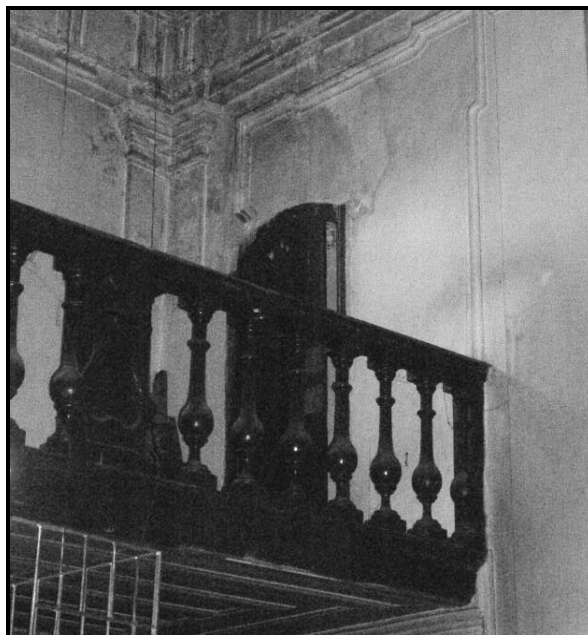
Fig. 2 - Balcão com a porta de acesso à residência Fonte: Domingos Oliveira, 2009
